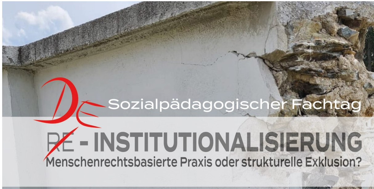
Abbildung 12: Bild einer abbröckelnden Wand mit dem Titel des Fachtages © IfEB
